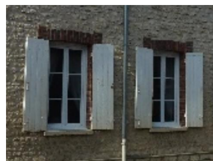
Photo 19 : Encadrement de baie en brique rouge, (photo Urbanea, 2021)
