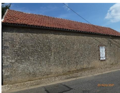
Photo 18 : Façade en pierre, ravalée en béton, (photo Urbanea, 2021)
