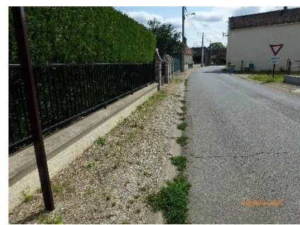
Photo 22 : Trottoir en stabilisé, (photo Urbanea, 2021)
