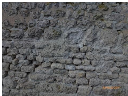
Photo 14 : Mur en pierre calcaire, (photo Urbanea, 2021)
